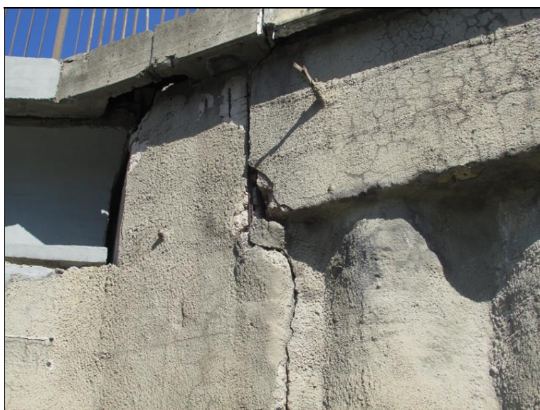
Povrch boku opěry ze stříkaného betonu opadává
