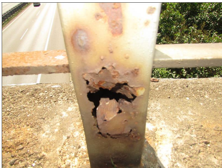
Koroze sloupku zábradlí
