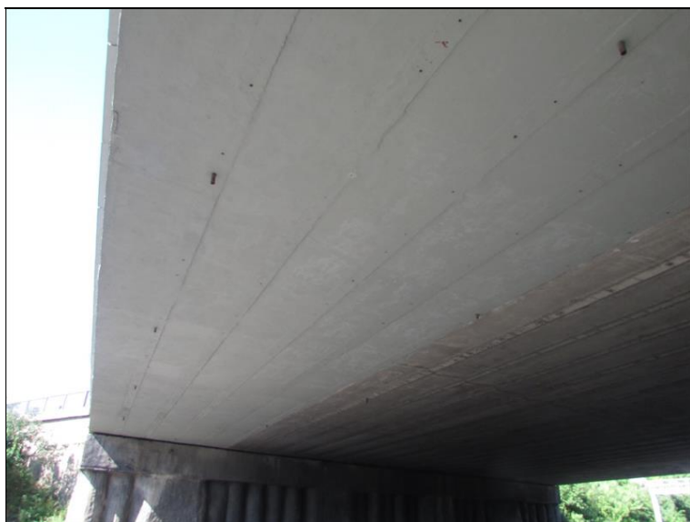
Sanace podhledu na pravé části NK
