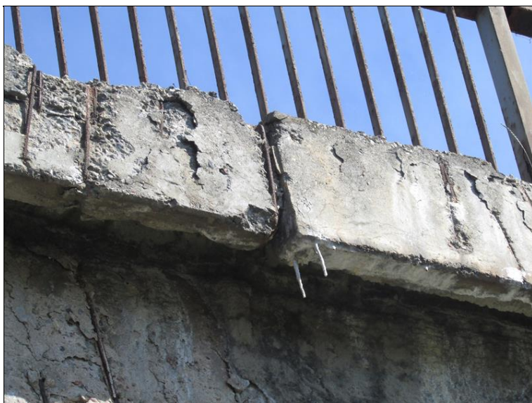
Degradace povrchu římsy
