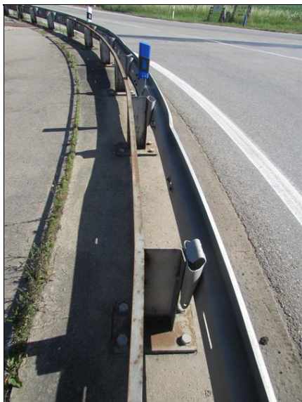
Deformace svodidla
