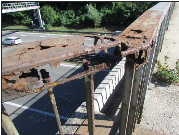
Koroze zábradlí U OP1 vlevo
