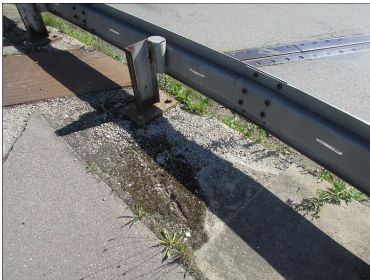
Deformace distančních prvků svodidla
