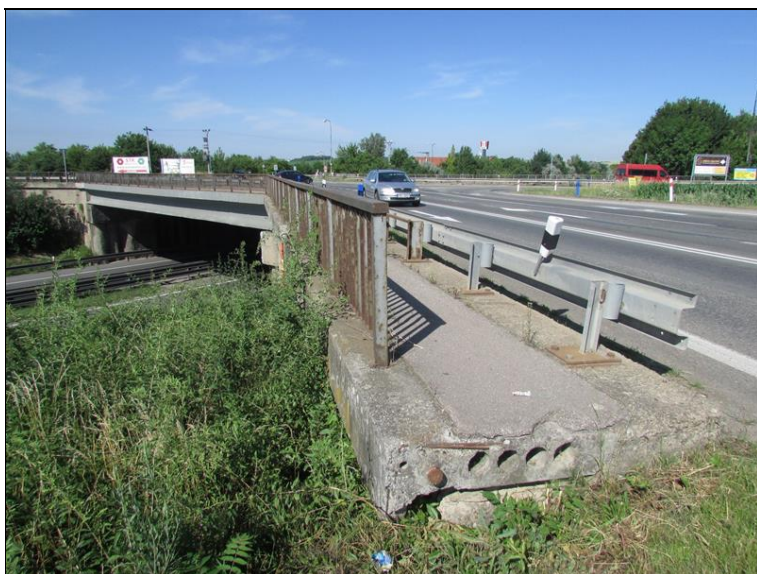
Absence napojení římsy na terén
