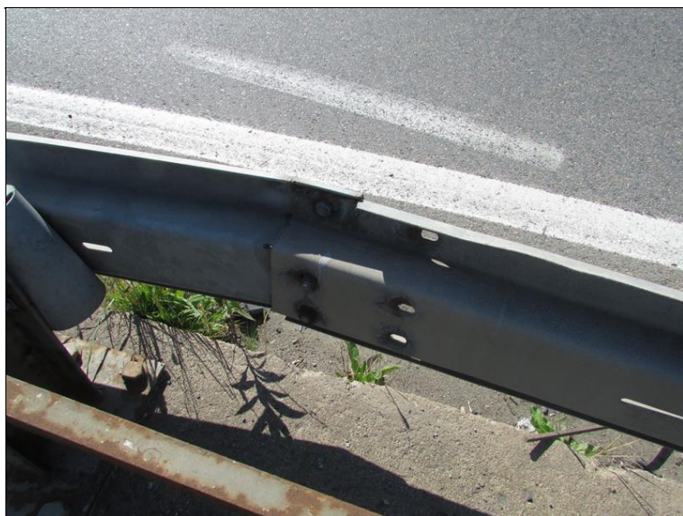
Chybné napojení svodnice - nekompletní přesah a šroubové spojení
