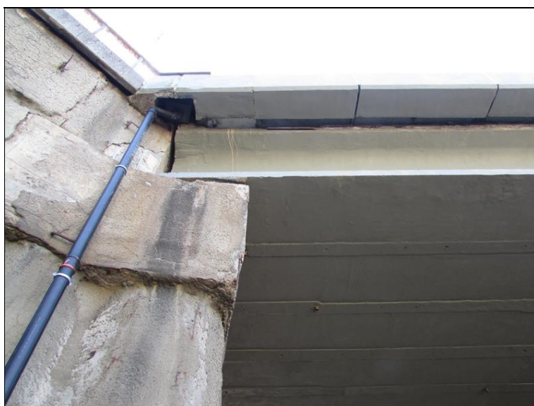
sanace levého boku NK a nový svod odvodnění žlabu
