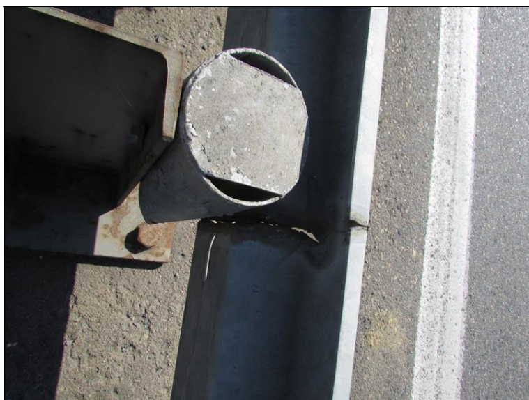
Deformace distančních prvků svodidla
