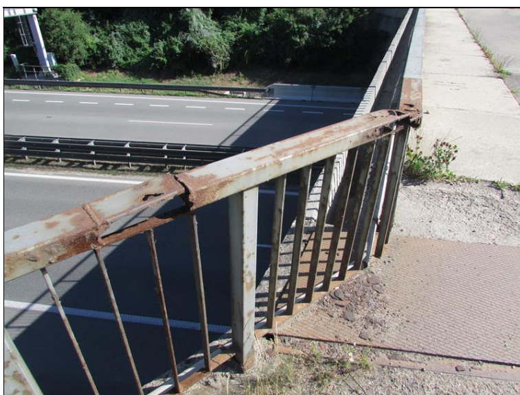
Koroze zábradlí U OP1 vlevo
